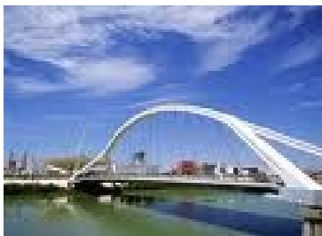
Puente de la Barqueta
